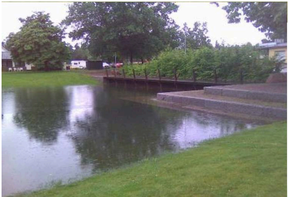
Exempel på dagvattenhantering med översvämningsytor i Växjö.
