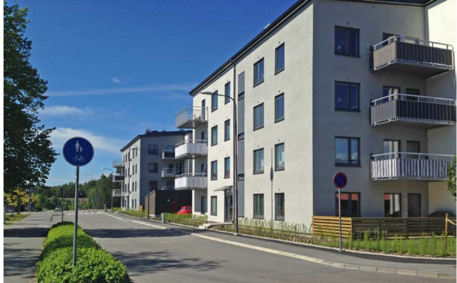
Exempel på fyrvånings bostadshus med putsad fasad.
